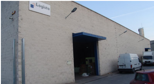
La nau de la distribuïdora Logista a Celrà està situada al carrer Llevant i està dedicada al sector tabaquer. Foto: Q. FERNÁNDEZ.
