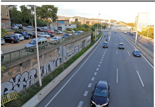
Un tram a tocar la C-31 on en breu s'iniciaran les obres del lateral Foto: JUANMA RAMOS.
