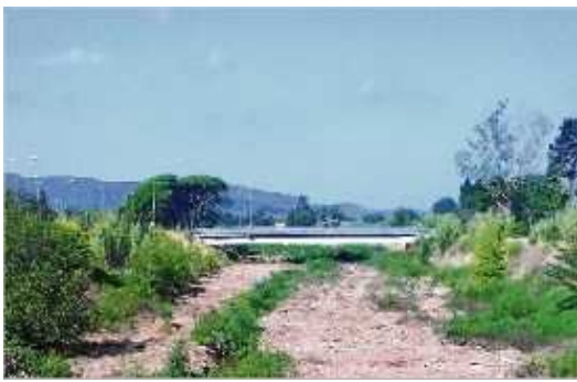
La llera del riu, al seu pas per Castell-Platja d'Aro, després de l'actuació.
