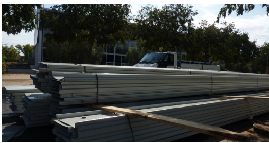
Les planxes per a la nova coberta del pavelló, a punt per ser instal·lades. Foto: R. E.
