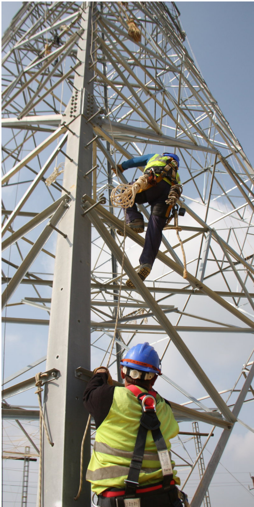
Dos operaris treballant en una de les torres d'alta tensi Foto: XAVIER PI.
