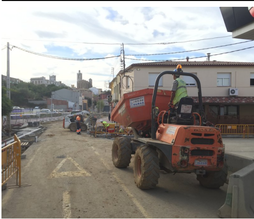
Les obres de la tercera fase de les obres de reconversió de la C-65 van començar dilluns passat Foto: CANAL AJUNTAMENT.
