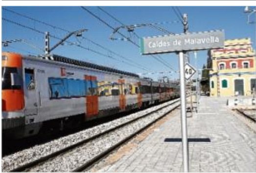
L'estació de Caldes de Malavella, on Adif hi fa un pas inferior i la modernitza per 3,1 milions d'euros.
