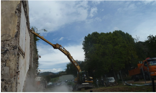
Un detall dels treballs que estava duent a terme ahir una de les màquines pensants a l'edifici de Can Marcé. Foto: J.C.
