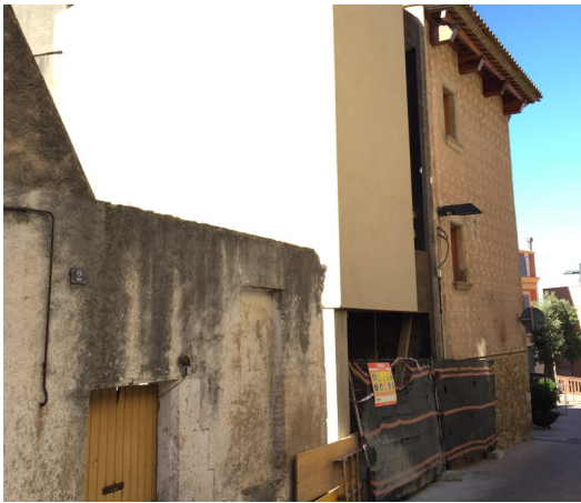
L'escala i l'ascensor s'han ubicat en un nou cos que s'ha construït en un terreny annex al característic edifici Foto: EL PUNT AVUI.
