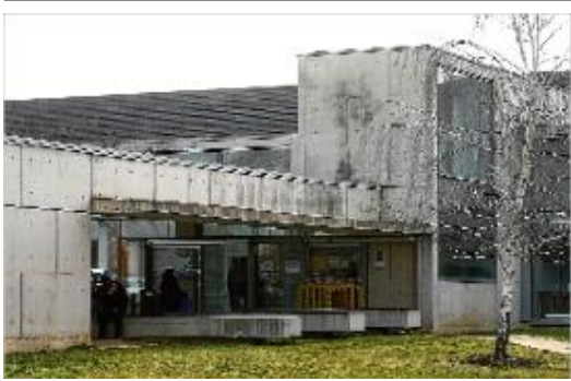
Salt serà centre de referència al Gironès, Pla de l'Estany i Selva Interior.
