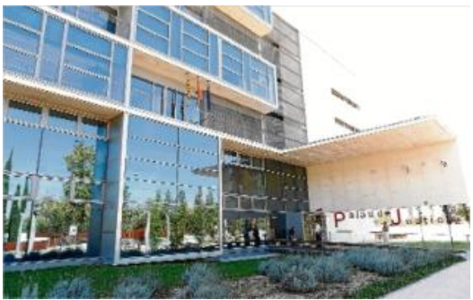
Girona va fer la prova pilot d'implementació de la nova oficina judicial al Palau de Justícia.
