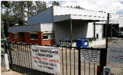
Olot ha tancat la planta de transferència de residus per fer obres de millora
