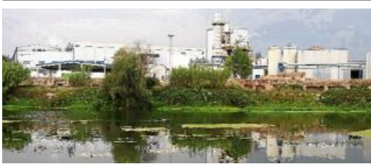
Instal·lacions de Torraspapel, al costat del riu Ter a Sarrià.
