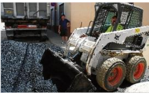
S'inicia l'asfaltatge de dos carrers ganxons
