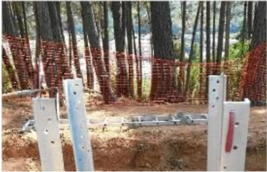
Imatge de la construcció de la nova torre de telefonia mòbil a Arbúcies.
