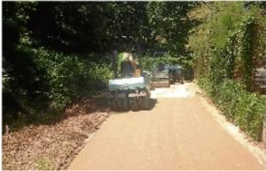
Imatge dels treballs per pavimentar el camí.
