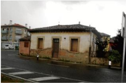
La casa que enderrocaran en els propers dies, a l'avinguda de Sant Joan de les Abadesses d'Olot.
