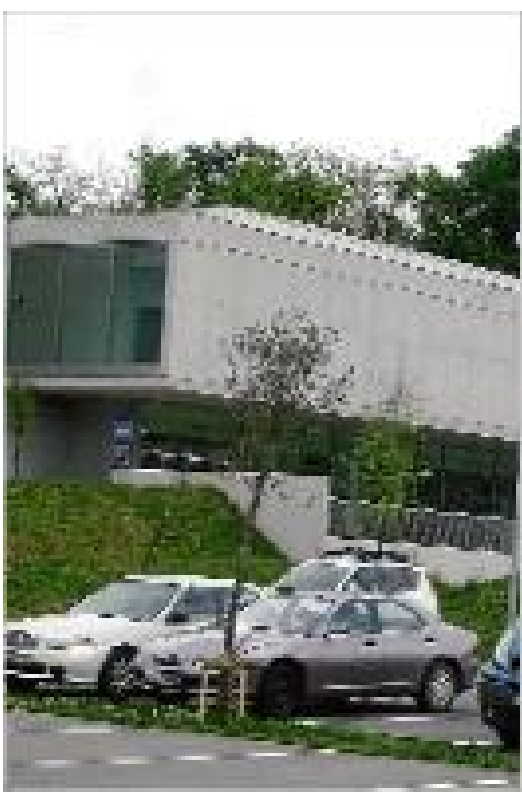
Aparcament de l'Hospital d'Olot.
