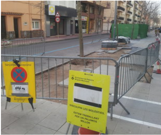
Una de les voreres de Palamós on s'està efectuant treballs aquesta setmana. Foto: EL PUNT AVUI.
