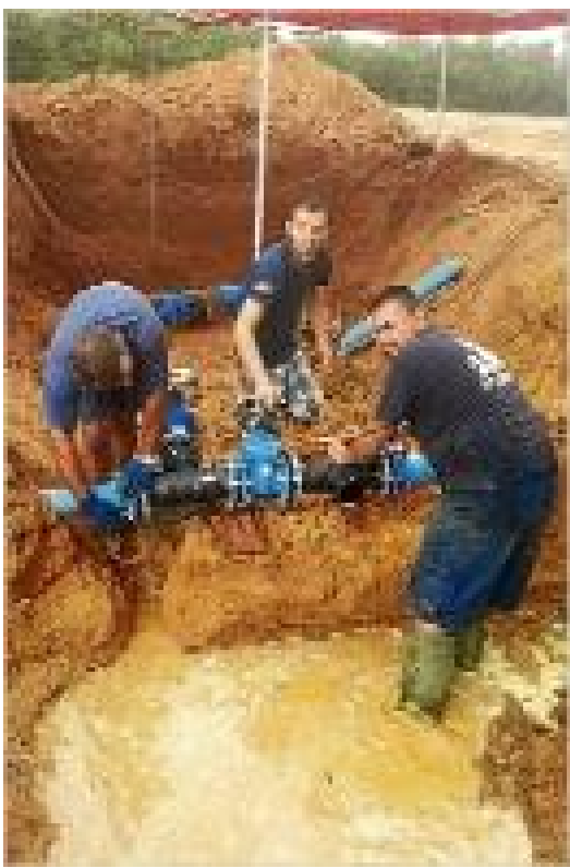
Una connexió d'aigua a Llagostera.
