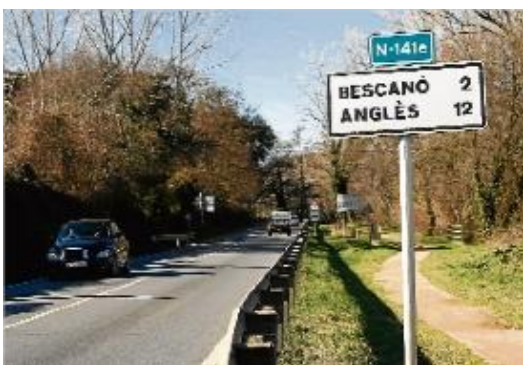
Una imatge d'arxiu del tram entre Bescanó i Montfullà de la N-141.
