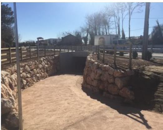
El nou túnel vist per la banda més propera al Ter. A l'esquerra queda Salt i a la dreta Bescanó. Foto: J.N.
