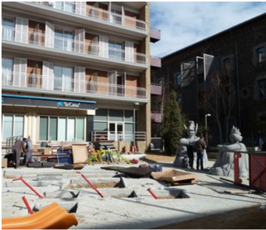
Una vista del parc en obres. Foto: J.C.
