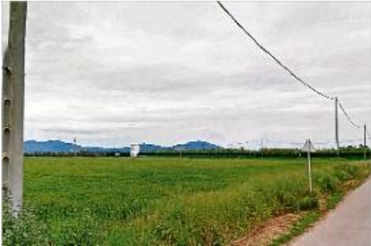
La línia elèctrica abans de ser retirada de la zona.
