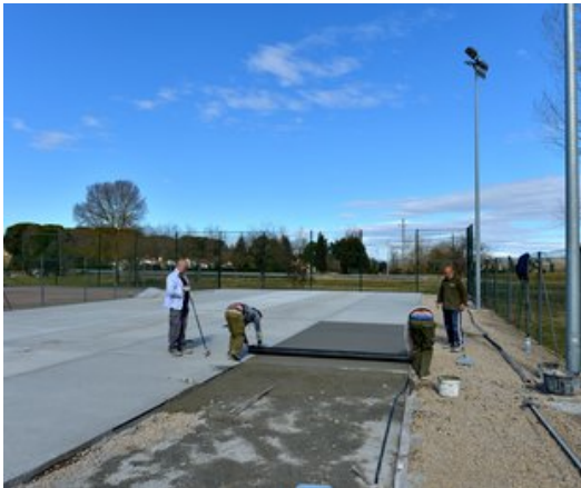
Operaris posant el paviment en els darrers treballs que s'han fet a les primeres pistes de tennis Foto: CANAL AJUNTAMENT.
