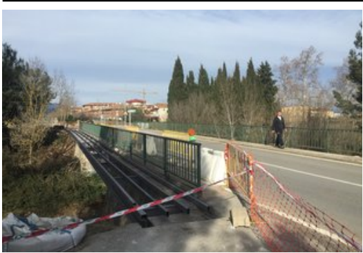
El pont de la riera Palagret amb l'estructura adossada en la qual anirà el carril bici Foto: J.N.
