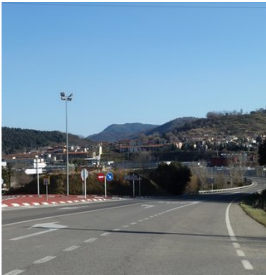
Una vista de l'actual ronda urbana que fa de variant nord al seu pas pel barri de l'Hostal del Sol d'Olot. Foto: J.C.
