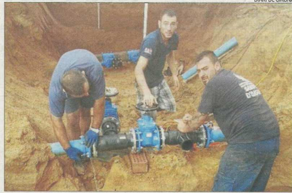
Treballs de connexió d'aigua entre Caldes i Vidreres el passat 21 d'agost.
