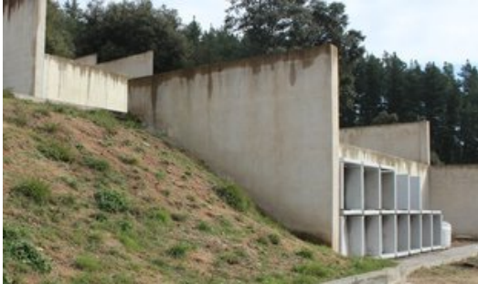
Una imatge recent de les instal·lacions del cementiri municipal d'Arbúcies Foto: AJ. D'ARBÚCIES.
