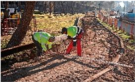
Les obres a Caldes del sender d'11 km que unirà el Golf amb el Carrilet.
