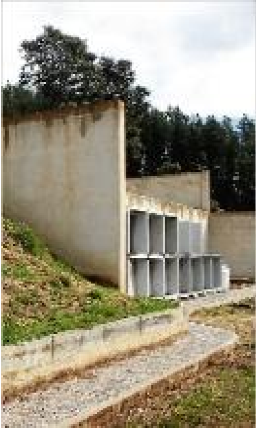
La zona d'ampliació del cementiri.
