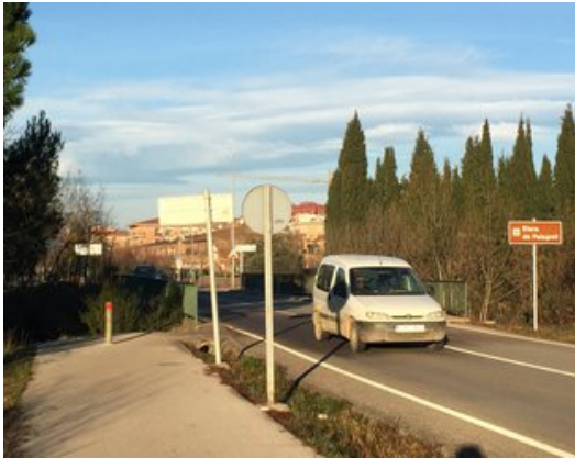
El pont de la riera Palagret, amb el carril bici, a l'esquerra, que queda tallat Foto: J.N.
