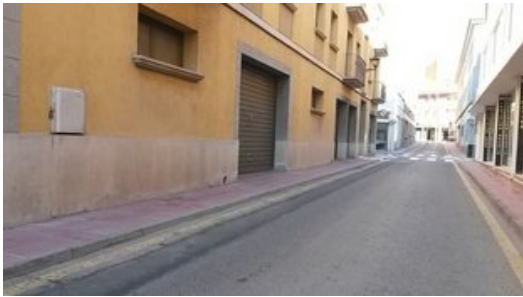
Imatge de la zona del soterrament. Foto: ENDESA.
