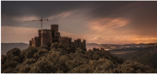
Comencen les obres de restauració del castell de Montsoriu d'Arbúcies
