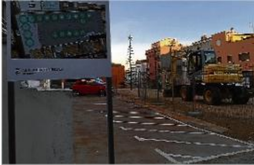
Les màquines ahir al matí treballant al solar.
