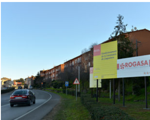
La C-65, al seu pas per Llagostera, ahir a la tarda, un cop ja iniciats els treballs preliminars de les obres Foto: J.T.
