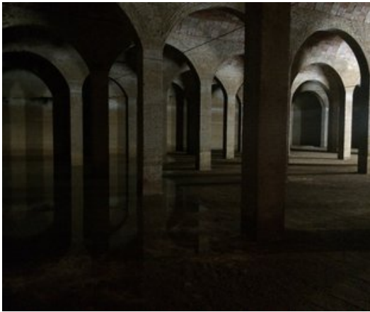
El dipòsit subterrani de recollida d'aigües pluvials del rei Martí, situat a Sarrià-Sant Gervasi Foto: AJUNTAMENT DE BARCELONA.
