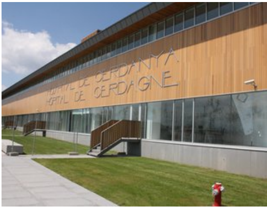
Façana de l'hospital de la Cerdanya. Foto: JORDI CASAS.
