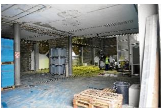
L'estat actual de la Llotja dels pescadors de Llançà, on han començat les obres per refer-la.
