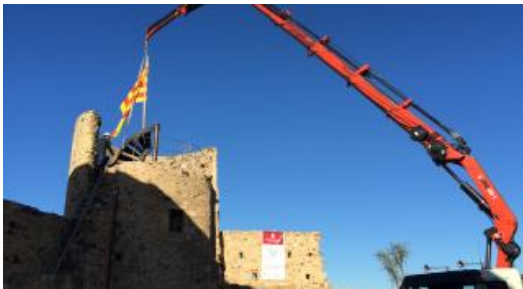
La torre de la presó de Llagostera es reobrirà reformada en mirador
