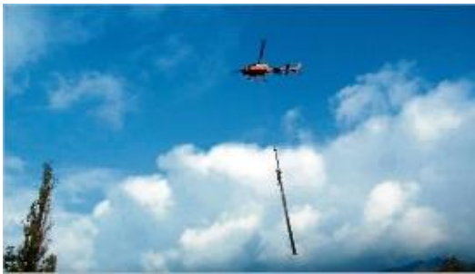
L'helicòpter transportant un dels pals del tram de la línia renovada.
