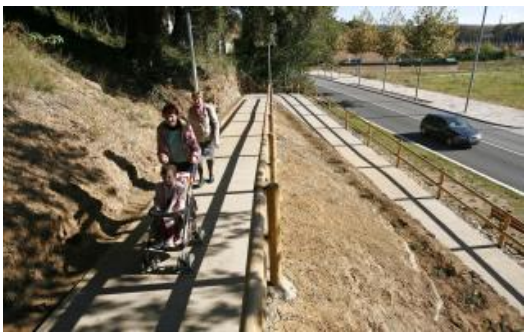
La nova rampa que uneix el carrer Sant Gregori i el d'Adri ·
