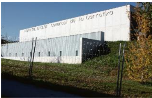
Les noves instal·lacions de l'hospital d'Olot, que dilluns estaran plenament operatives.
