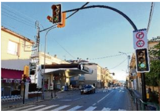
Estat actual de l'antiga C-65 que travessa el poble de Llagostera.
