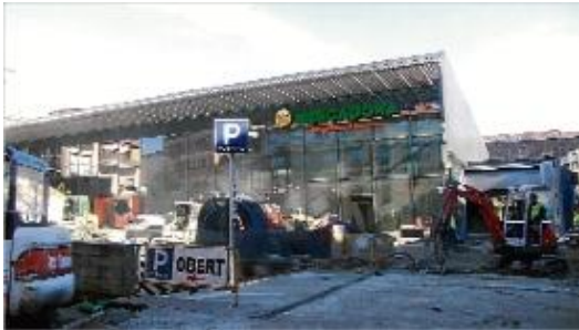
Les obres de la plaça en plena activitat, ahir al matí.
