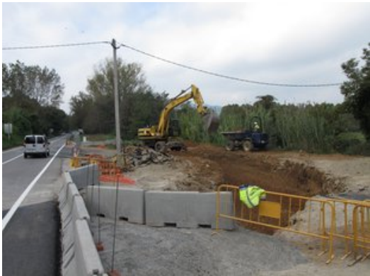
Maquinària treballant per fer la rampa del futur túnel. A l'esquerra, l'N-141e, a l'alçada de Montfullà Foto: J.N.
