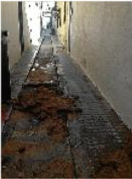
Obres en un carrer del nucli antic.
