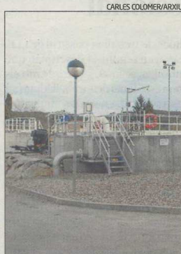
La planta depuradora d'Anglès.
