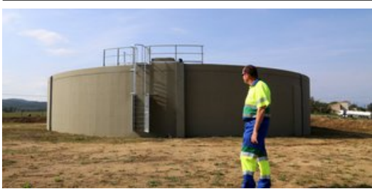
El nou dipòsit de Can Pinet té una capacitat total de 2.000 m 3 . Foto: QUIM PUIG.
