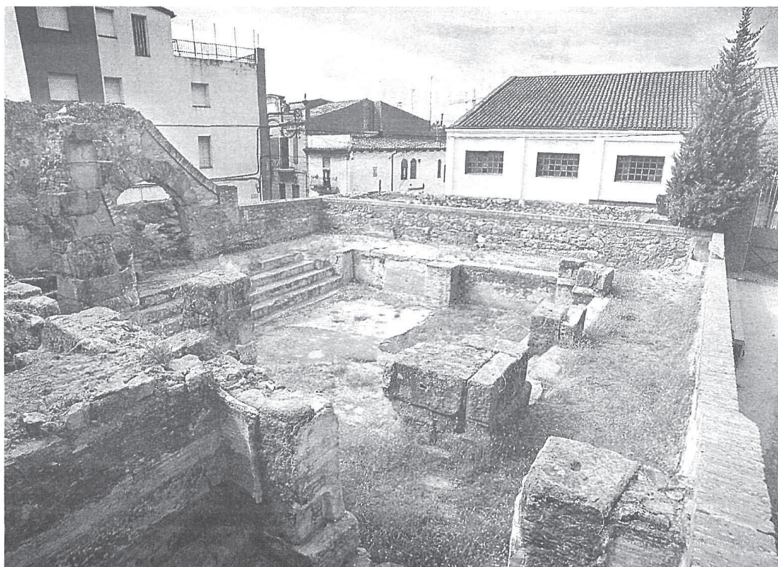
Les termes romanes de Caldes de Malavella formaven part del nucli d'« Aquae Vocconiae », sorgida a partir d'una «mansio» o àrea de servei de la via Augusta. La construcció envolta una gran piscina central de planta rectangular. Al voltant s'hi poden veure quatre ambulacres, i cap a llevant, tres cambres que han estat considerades piscines individuals. / M.LL.
